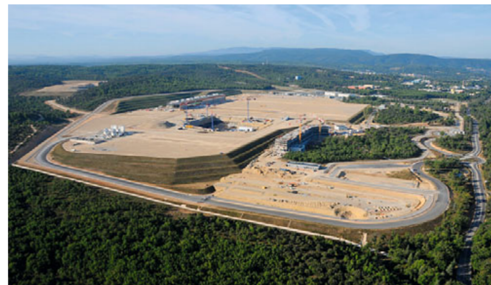
Celkový pohled na staveniště tokamaku ITER. Vlevo nahoře hala pro montáž cívek poloidálního magnetického pole a před ní jáma pro reaktor. Snímek z balonové sondy pořízený v září 2011.
