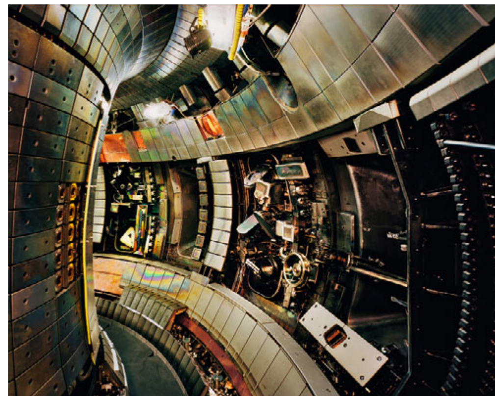
Vnitřek vakuové komory tokamaku ASDEX Upgrade – Garching u Mnichova
