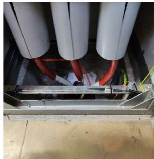
Obr. 2: Rozvaděč 9BA.15 – provedená oprava optického vlákna pomocí spojky
